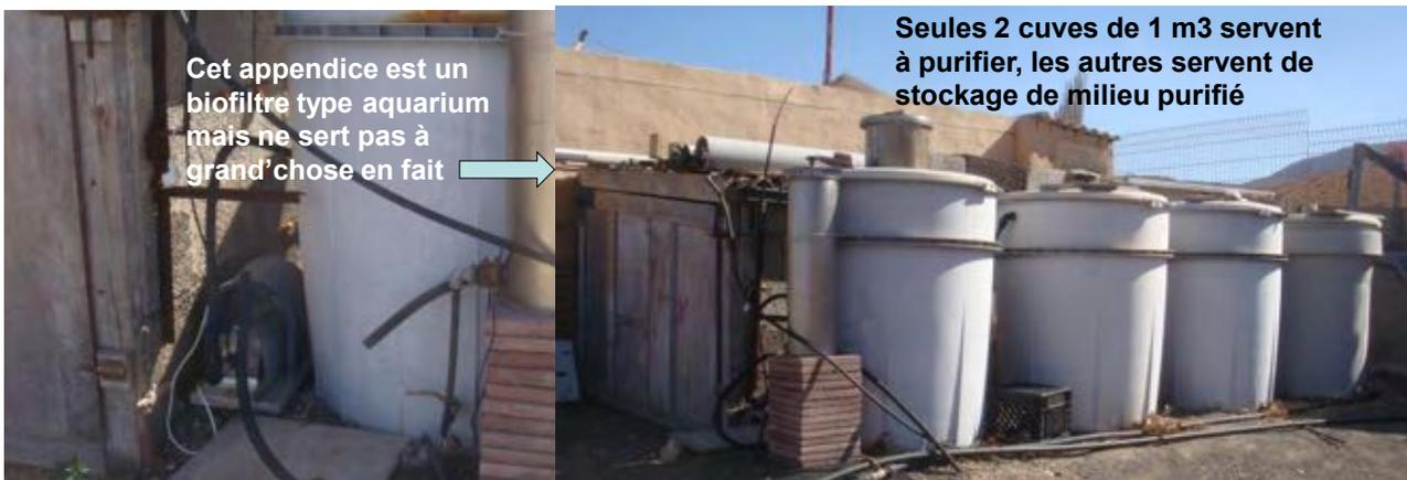
**L'eau sortant de la 1<sup>ère</sup> cuve va dans la 2<sup>nd</sup>e et la pompe émulsionneuse puise dans la seconde**
