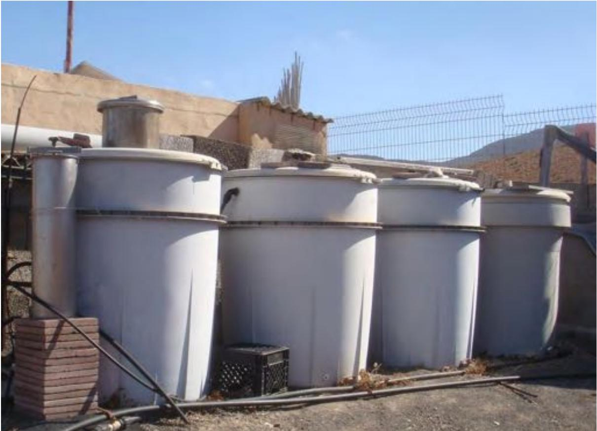
Le principe général est de soumettre le milieu à épurer à un traitement par une émulsion d'air produisant à la fois une puissante oxygénation et une mousse qui adsorbe déjà beaucoup d'impuretés (EPS, protéines). Cette mousse est concentrée et séparée puis envoyée au compost.
