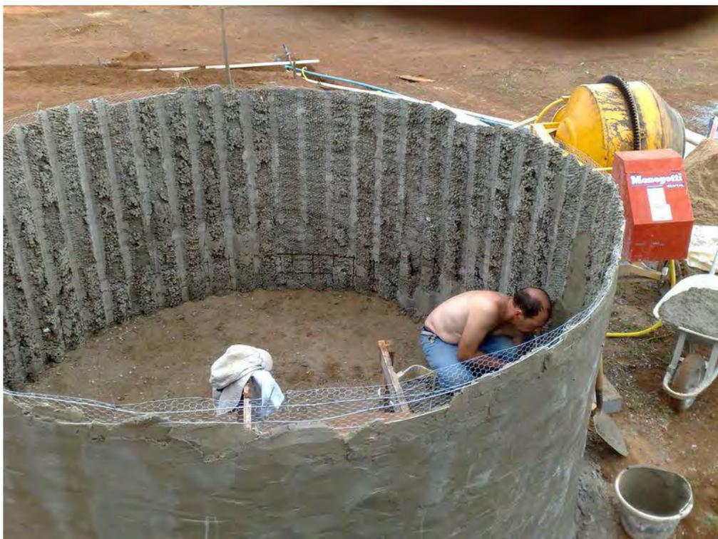
Réalisation d'un réservoir d'eau de 10 m<sup>3</sup>, 3 m de diamètre, avec du grillage à poules pour accumuler l'eau venant du puits (500 l/hr) tout au long de la journée. »
