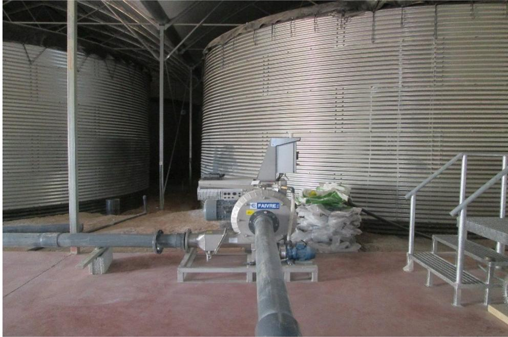
Stockage de chaleur en réservoirs économiques construits avec la technique des silos à grains :
