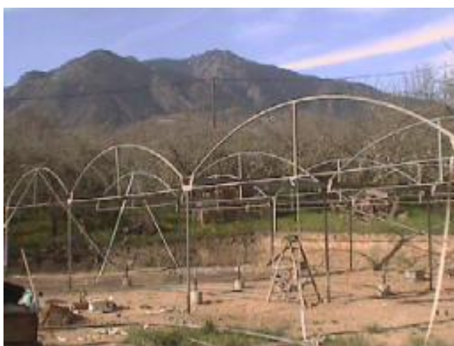
(CONSTRUCTION de la SERRE-MULTICHAPELLE, (Photo C. Lelièvre)
